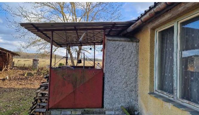
Vstupní přístřešek – boční pohled od SZ
