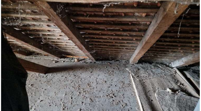
Půda - pohled na zvýšenou podlahu na původ. záklopu na krovu
