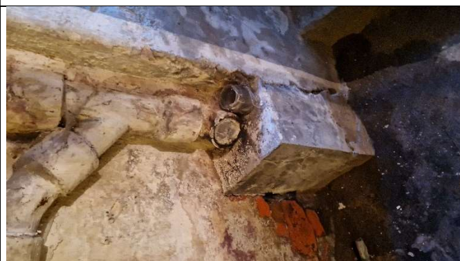
Kanalizace – patní koleno s revizním otvorem (v suterénu)
