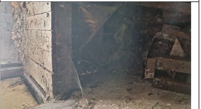
Půda - pohled na výškový rozdíl mezi podlahami půdy u schodiště
