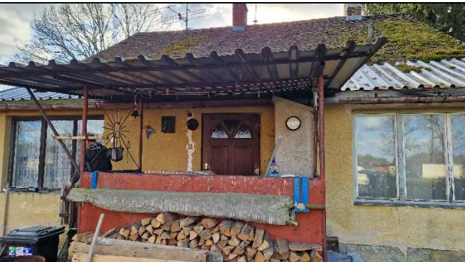
Vstupní přístřešek – celkový pohled od SV
