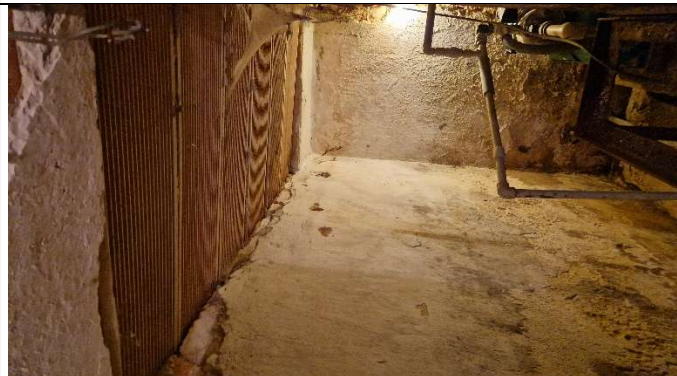
Suterén- prostor bez oken-zdivo i omítky degradovány vlhkostí
