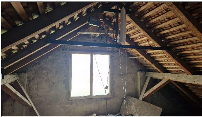
Půda - pohled na JV štítovou stěnu a střešní krov s ležatou stolicí
