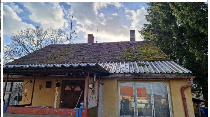
Šikmá střecha - pohled na střechu od SV
