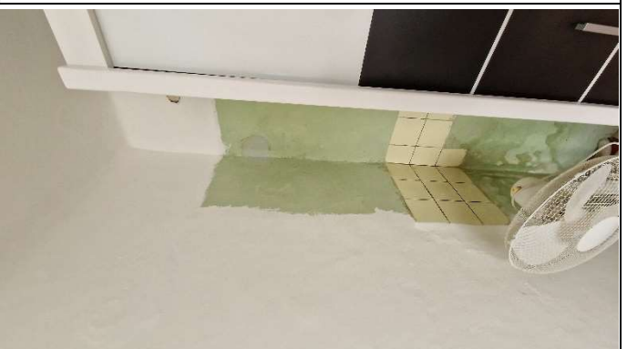
Přízemí – JZ obývací pokoj, pozůstatek bývalého kuch. koutu
