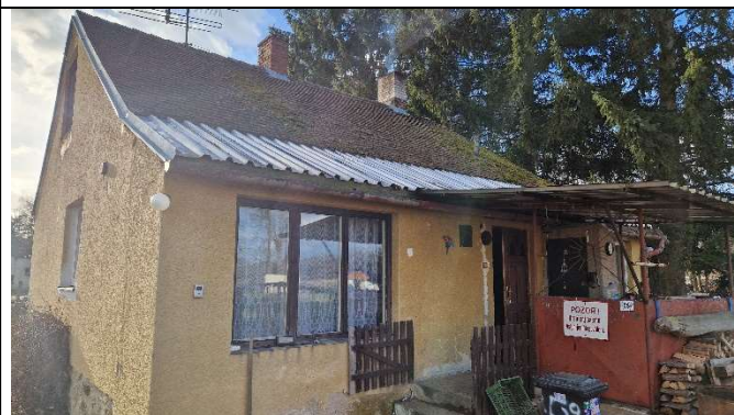
JV a SV fasáda-přístavba pokoje a vstupu, vstupní přístřešek
