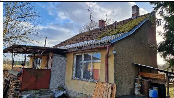
SV a SZ fasáda- vstupní přístřešek, přístavba chodby a kotelny
