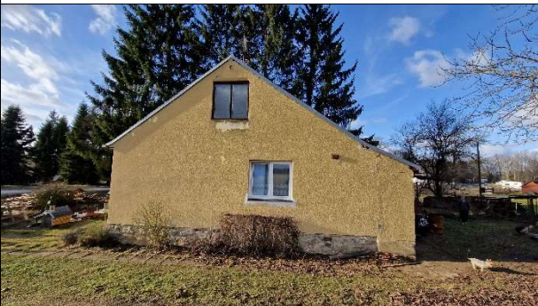
JV fasáda RD, příjezd od vrat, zpevněný chodníček
