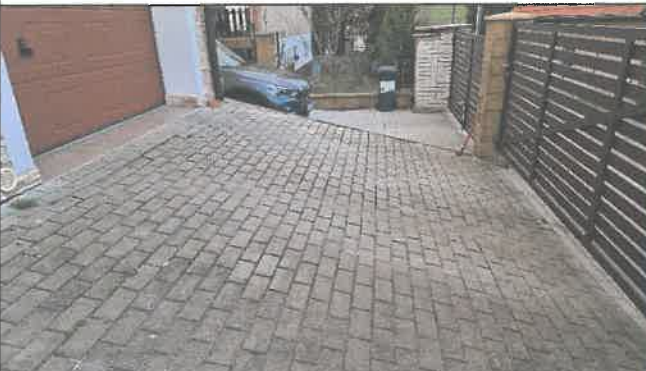
Zpevněné plochy u domu – nájezdová rampa do garáže
