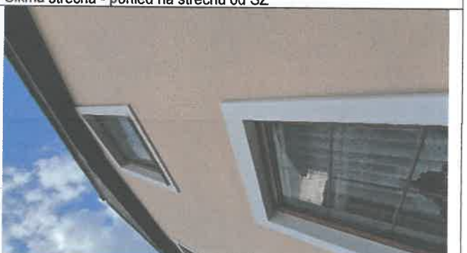
Šikmá střecha - pohled na JZ část střechy
