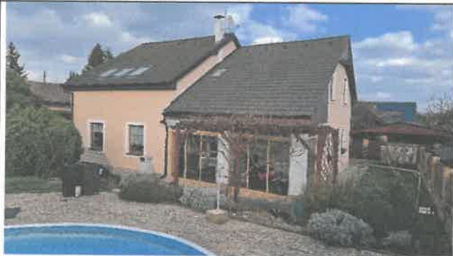
Šikmá střecha - pohled na SZ a JZ část střechy
