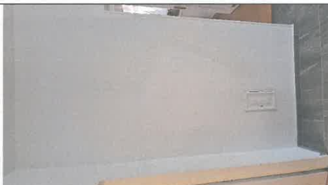
Přizemí – prostor chodby, jídelny- kominová stěna
