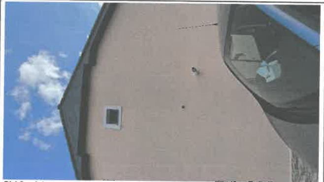
SV fasáda- uprostřed stěny odkouření kotle a odvětrání garáže
