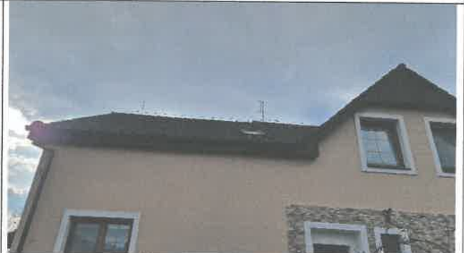
Střecha - pohled JV část
