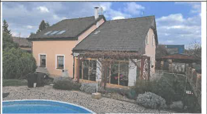
Technické zařízení – hromosvod a TV anténa na stožáru na střeše
