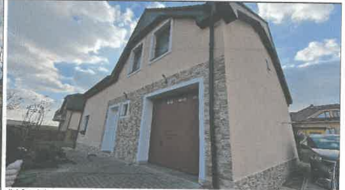
JV fasáda, vstupní prostory do domu a garáže, parking u štit stěny
