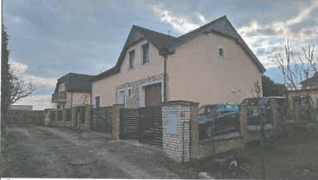
Střecha - pohled na JV a SV část střechy
