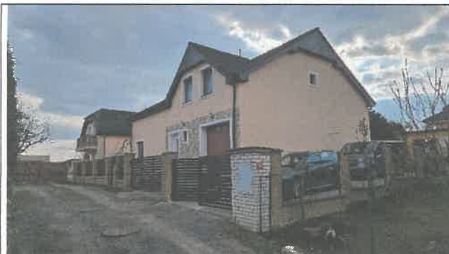
Elektro – elektroměrový rozvaděč v pilířku před oplocením, v komunikaci je patrný poklop přípojovací šachty kanalizace
