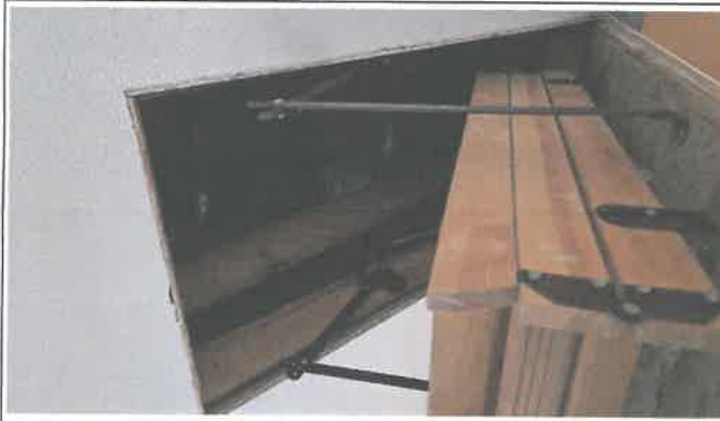
Půda - pohled na vstupní skládací schody, podlaha půdy není pochozí
