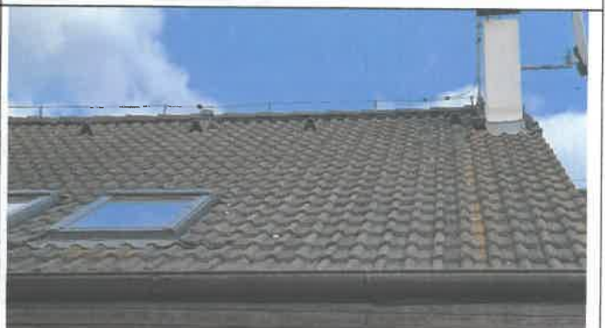
Šikmá střecha - pohled na střechu od SZ
